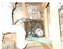
JCV型 pH12.5、液温70℃、シリカ混入 大手製鉄所へ納入
