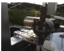
M型 排水処理薬液注入
